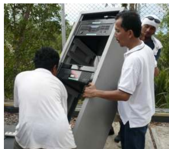
Para teknisi sedang memasang satu unit repeater di Bukit Argopeni, Kebumen
